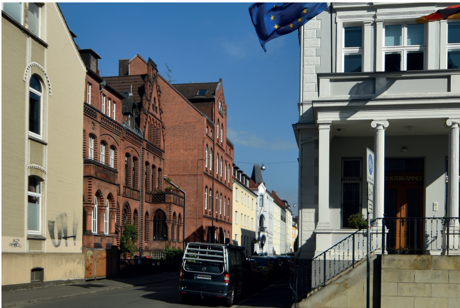
Abb. 1: Die städtebauliche Einbindung des Doppelhauses, v. l. n. r.: Eckhaus Uhlemeyerstraße 15 (1866), zurückgesetzt Eichstraße 3/5 (1891, 1888), Eichstraße 7 (1897), vorn rechts Entrée des Verwaltungsgebäudes der Klosterkammer Hannover (1873/74) (Foto: Hansjörg Rümelin 2023)
