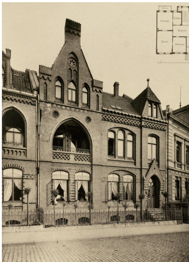
Abb. 4: Wohnhaus Hannover, Oeltzenstraße 22, nach seiner Fertigstellung (Max Kolde, 1884/86, Ausgeführte Backsteinbauten, Bl. 28)
