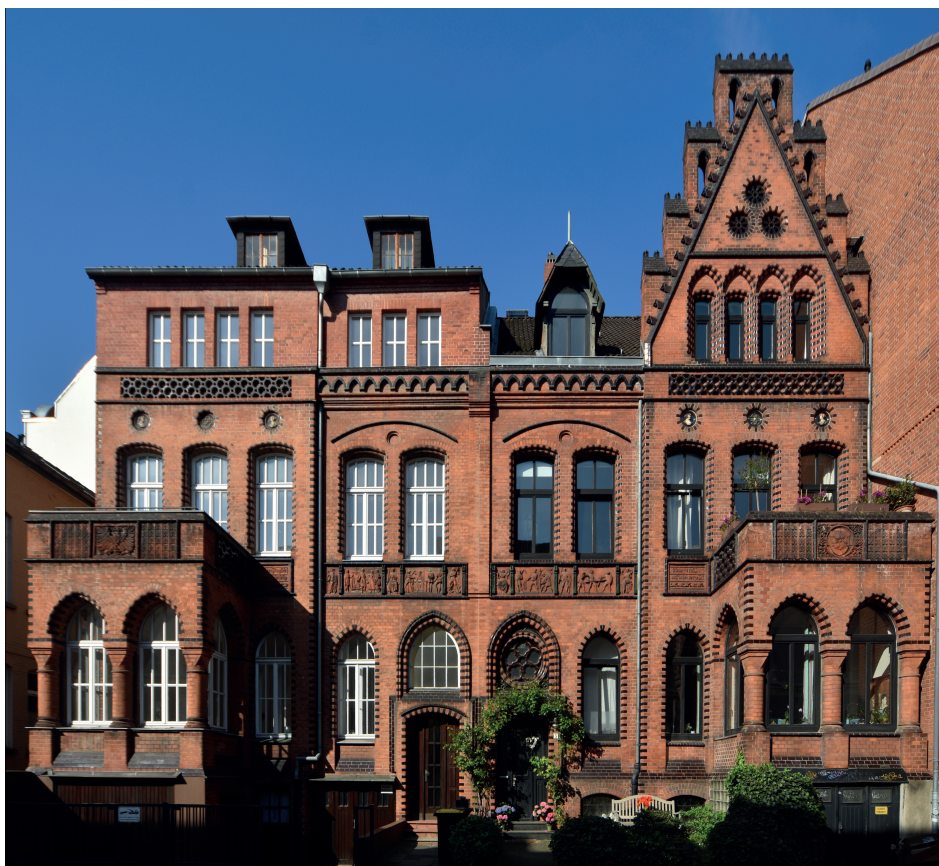
Abb. 3: Das Doppelhaus Hannover, Eichstraße 3/5, Zustand 2023 (H. F. A. Ilse, 1888/91, Foto: Hansjörg Rümelin 2023)
